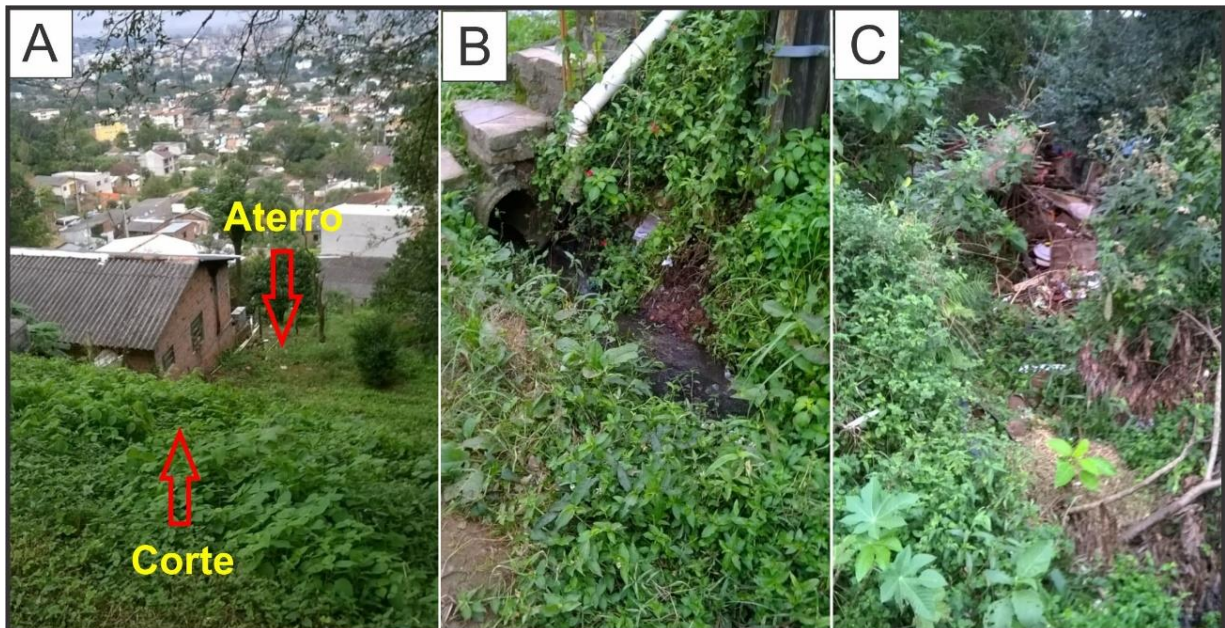
Figura 05 - (A) Área de ocupação com intervenções na encosta - corte e aterro. (B) Lançamento de águas servidas na encosta. (C) Lançamento/descarte de dejetos. Fotos realizadas no morro Cechella.
