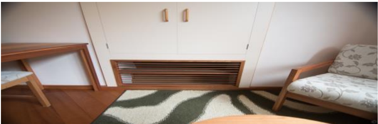
Figura 17- Abertura próxima ao piso
