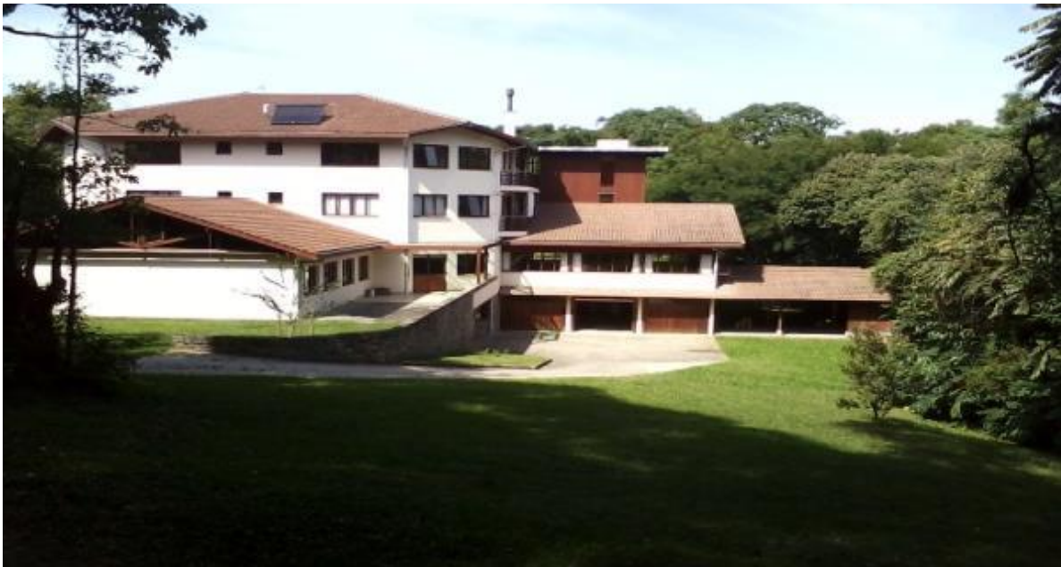
Figura 14- Edificação estudada em Itaara
