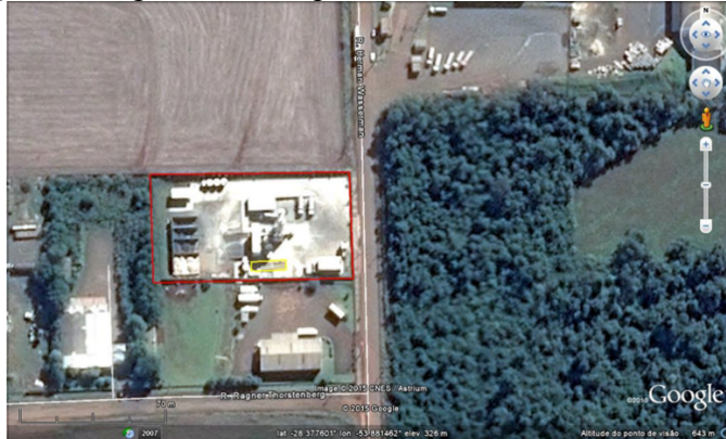
Figura 1 – Localização da empresa. Destaque em amarelo o decantador
