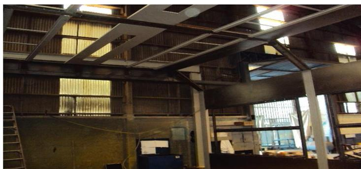
Figura 14 - Montagem da cabine pintura.
