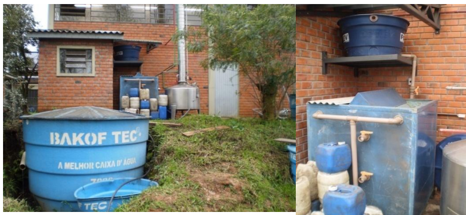
Figura 2 – a) Instalações externas da microdestilaria; b) Reator UASB para tratamento da vinhaça
