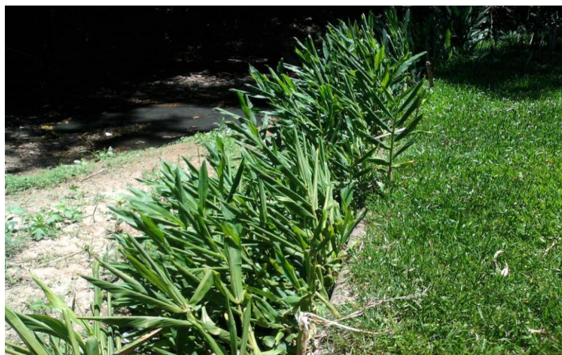
Figura 6 - Parede Krainer simples vegetada com Hedychium coronarium e o talude estabilizado com leivas de grama, 150 dias após o término da intervenção.
